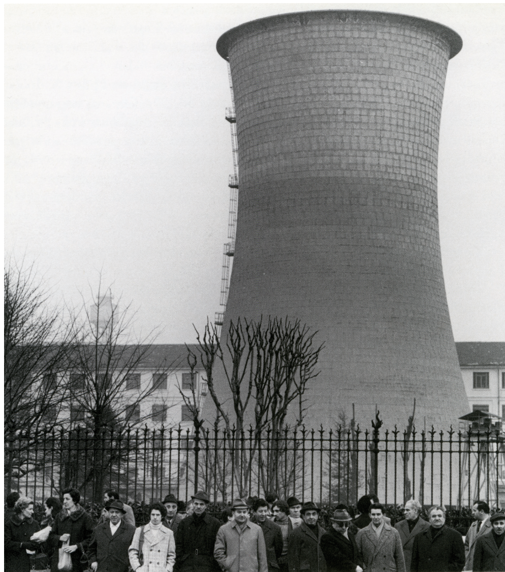
La torre di raffreddamento nello stabilimento Pirelli di Milano Bicocca, 1958
